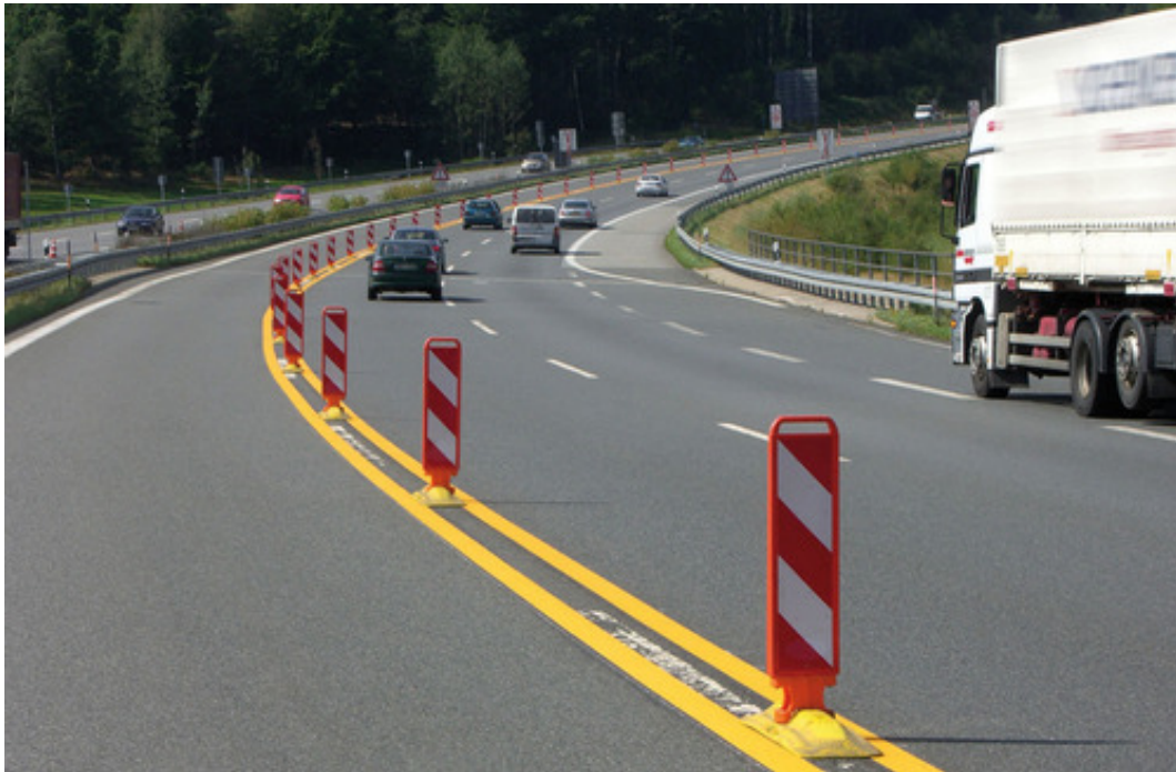
Схема 16 – Пример установки делиниаторов, оснащенных пластинами
